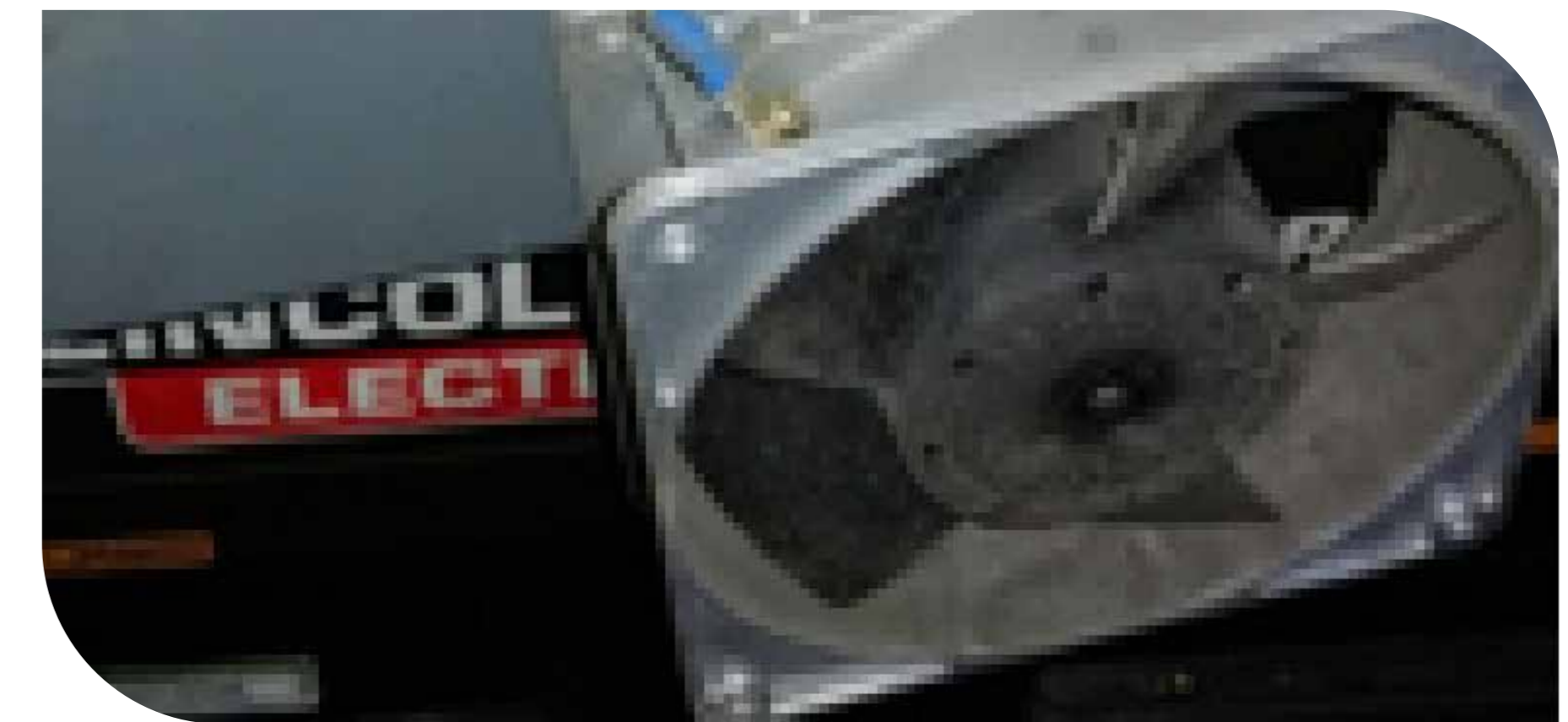
Limpieza de ventiladores
